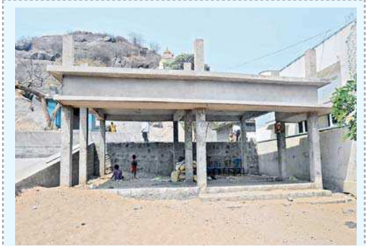
జి.కొండూరులో నృసింహస్వామి గుట్ట వద్ద నిలిచిన అంగన్వాడీ భవన నిర్మాణం
